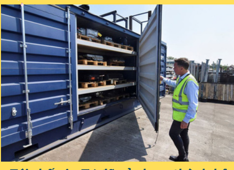
Tái chế pin EV đã sử dụng thành hệ thống lưu trữ năng lượng.
